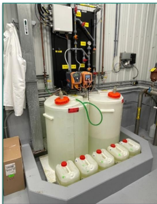
Photo 6 : Vue de l'entreposage de l'hypochlorite en solution à l'intérieur de l'usine.
